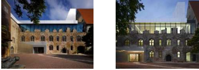
Şekil 9 :Moritzburg Müzesi Çağdaş Çatı Eki ve Cephe Tamamlaması (URL32-33)
