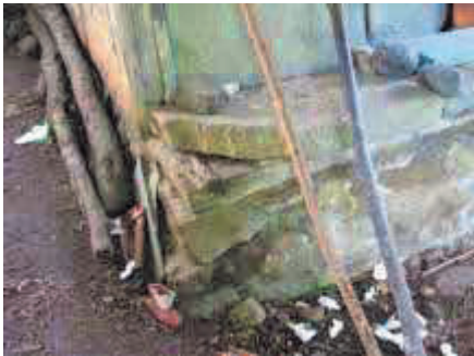
Fotoğraf 23. Yusuf Arslan Fırını ana yapı ahşap hatıl ve tezgâh ayrıntısı
