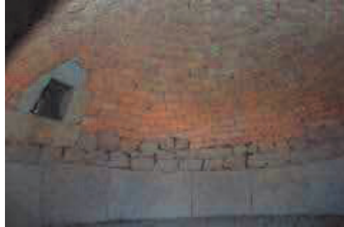
Fotoğraf 15. Mehmet Bircan Fırını pişirme hücresi içi (solda baca ağzı)
