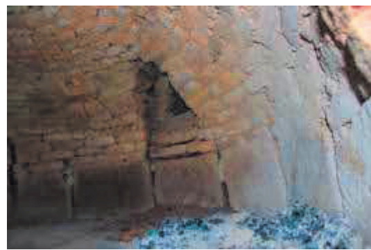
Fotoğraf 45. Muhittin ve Melek Şensoy Fırını pişirme hücresi bacası ağzı ve kubbe ayrıntısı
