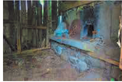
Fotoğraf 27. Cemal Bal Fırını ana yapı ön cephesi
