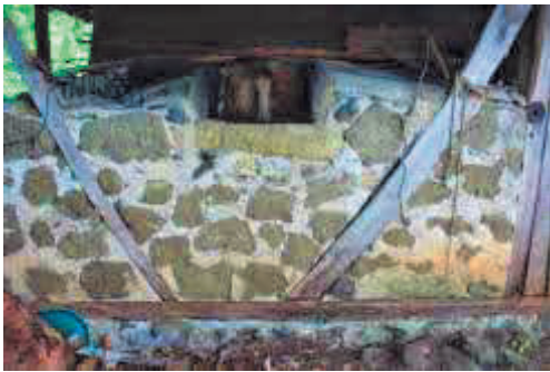
Fotoğraf 16. Mehmet Bircan Fırını ana yapı batı cephesi ve bacası
