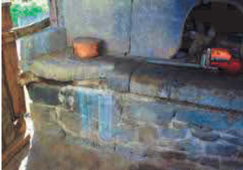
Fotoğraf 7. İsmet Şensoy Fırını ahşap hatıllı moloz taş duvar ve tezgâh ayrıntısı
