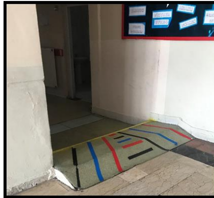
Şekil 4. Okul İçi Rampa.
